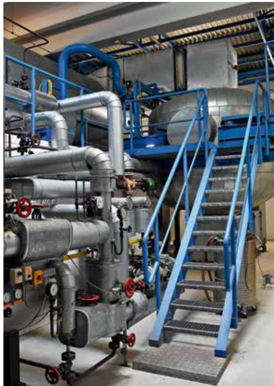
Katalytische Nachverbrennungsanlage zur Emissionsminderung
