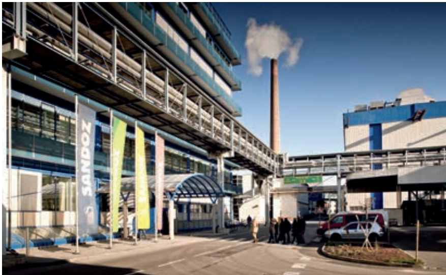
Die möglichst energieeffiziente Erzeugung von Prozessdampf mit Erdgas ist lange gelebte Praxis.
