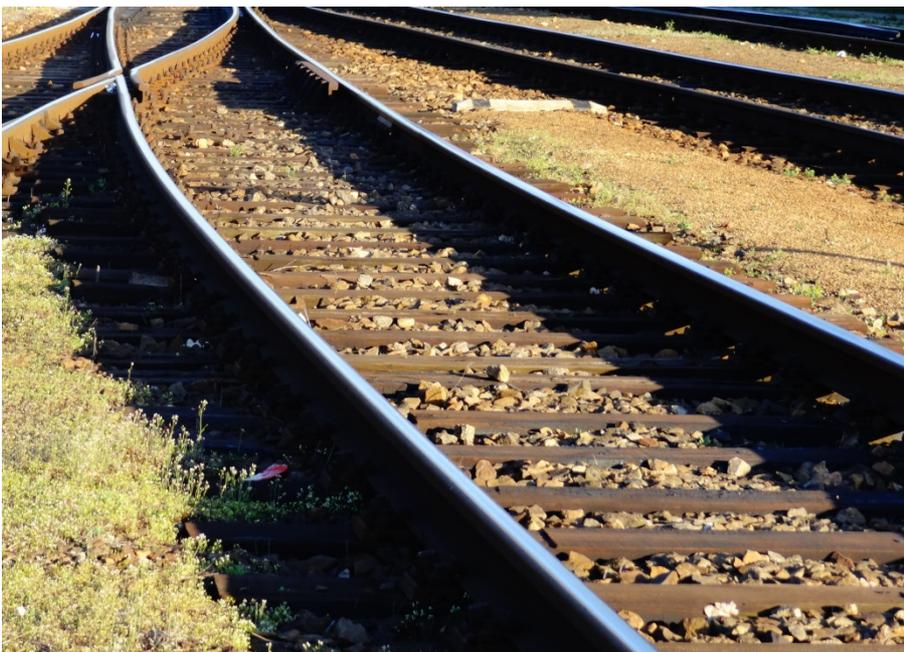
**Abbildung 1:** Bahnschwellen aus Holz, für einen effizienten Bahnbetrieb unerlässlich
